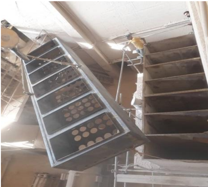
انتقال قطعات به محل سنگ شکن و جوشکاری فلانچ های داکت مکش فن در محل :
