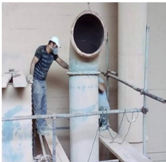
دمونتاژ داکت مکش هوای فن و نصب داربست:
