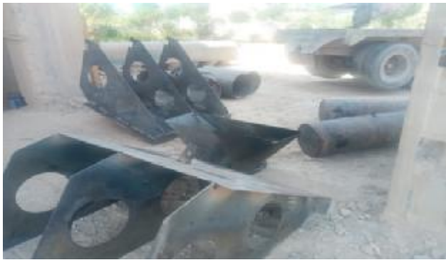
انتقال قطعات به محل سنگ شکن و جوشکاری فلانچ های داکت مکش فن در محل :
