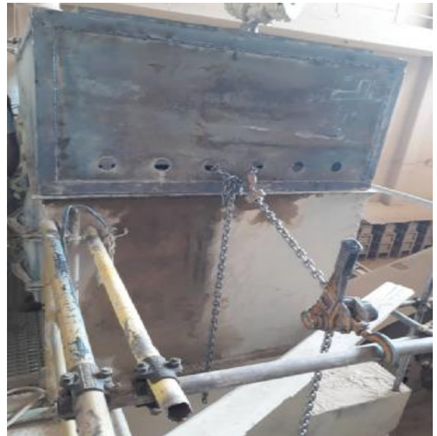
انتقال قطعات به محل سنگ شکن و جوشکاری فلانچ های داکت مکش فن در محل :
