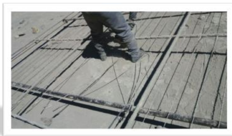
تصویر 24. بریدن و جداسازی الکترودهای معیوب و شل شده
