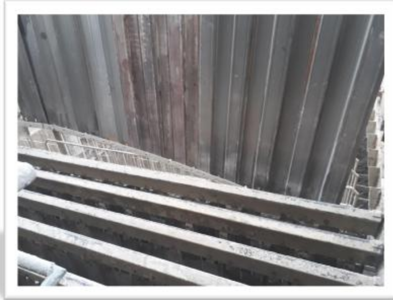
تصویر 33. نصب مجدد شاسی صفحات جذب پس از تعویض صفحات
