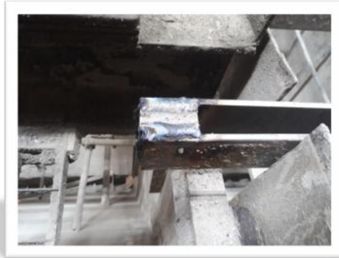
تصویر 36. اتصال (جوشکاری) سندانى به تسمه‌های رپینگ بار
