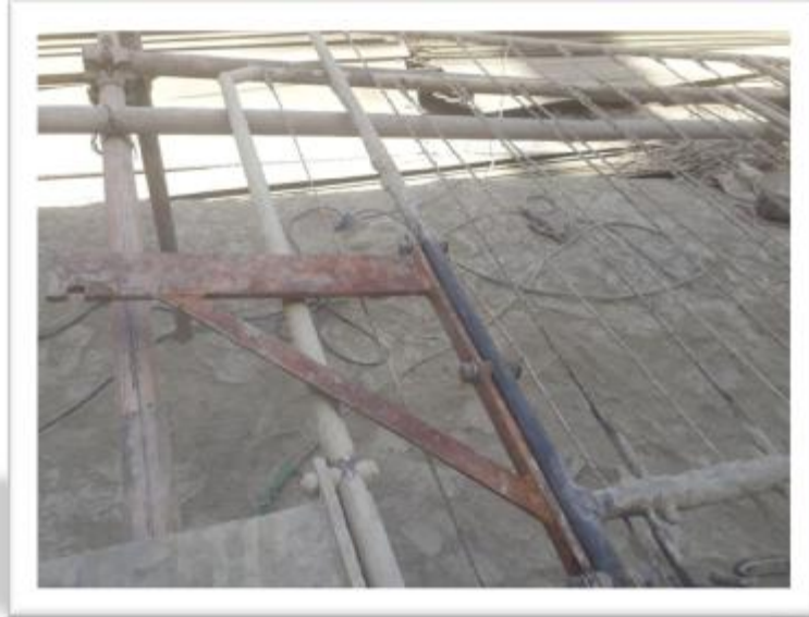
تصویر 26. ترمیم و تعویض بخشهای آسیب دیده شاسی الکترودهای دیسشارژ
