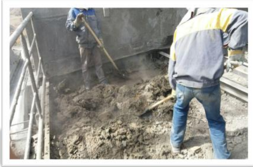
تصویر 14. نظافت و جمع آوری لایه عایق روی سقف
