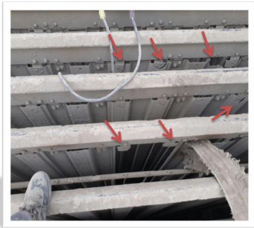
تصویر 2. شکستگی صفحات جذب از محل اتصال به گوشواره‌ها
