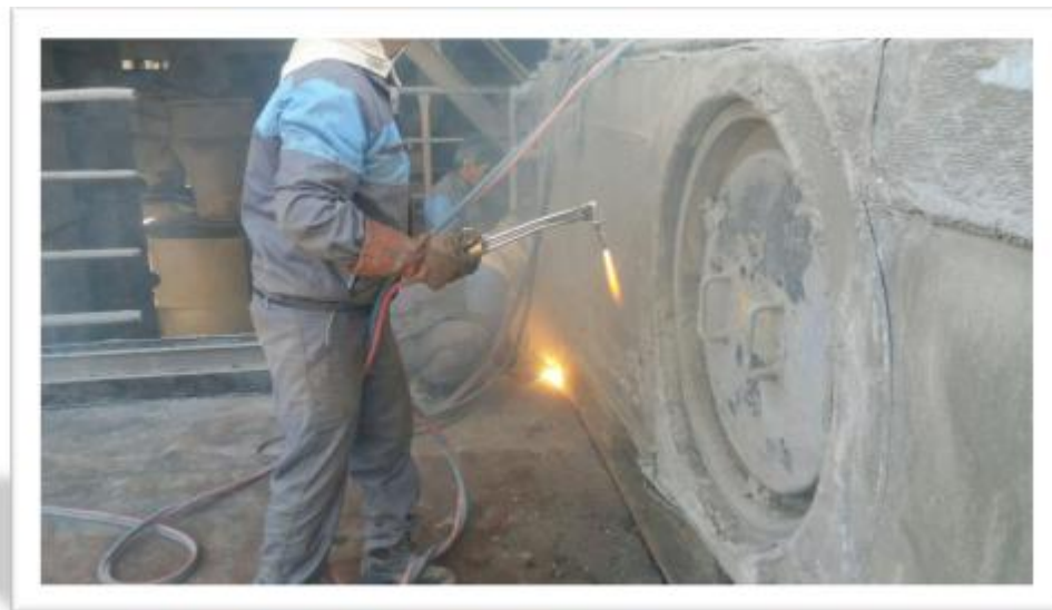
تصویر 17. برشکاری صفحه خوش خورده سقف الکتروفیلتر
