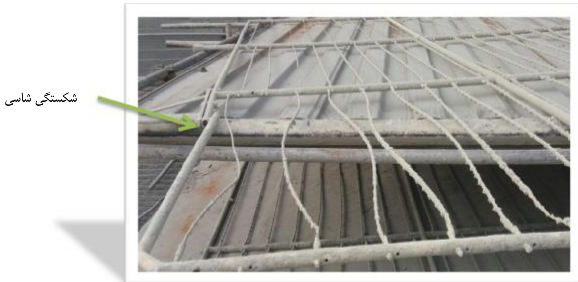
تصویر 5. الکترودهای شل شده به جهت تغییر شکل و بعضاً شکستگی شاسی
