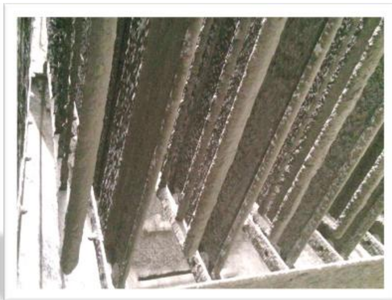
تصویر 7. کُت‌گرفتگی روی صفحات جذب و الکترودهای دیسشارژ
