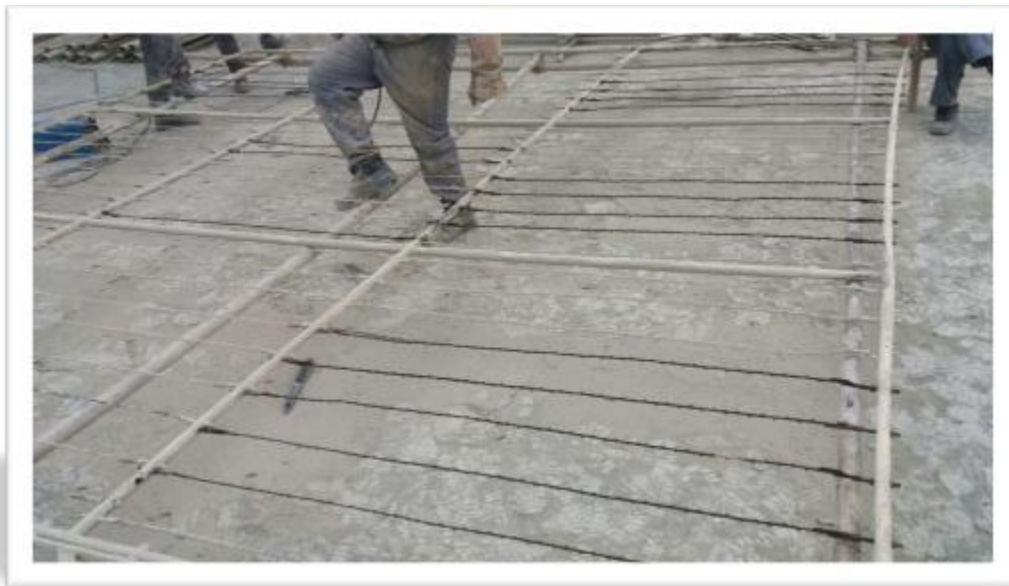
تصویر 25. نصب الکترودهای جدید روی شاسی
