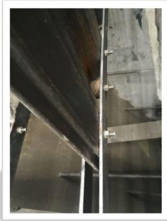
تصویر 35. اتصال صفحات جذب به تسمه‌های رپینگ بار توسط پیچ و مهره
