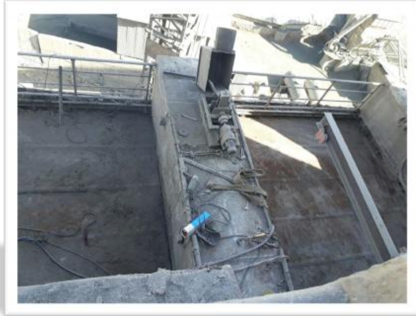
تصویر 16. سقف الکتروفیلتر پس از برداشتن لایه عایق و نظافت
