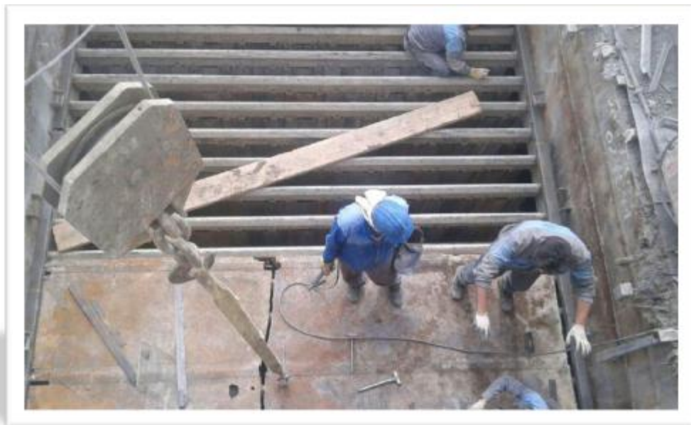
تصویر 37. نصب صفحات سقف
