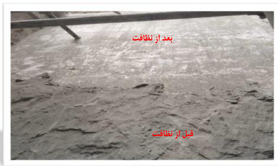
تصویر 29. نظافت کامل بدنه داخلی الکتروفیلتر
