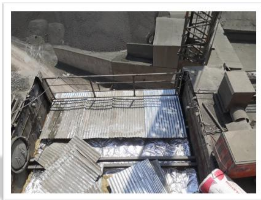
تصویر 38. نصب عایق پشم سنگ روی سقف
