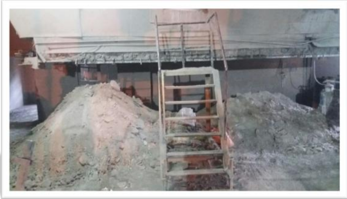
تصویر 32. ضایعات تخلیه شده از داخل الکتروفیلتر پس از نظافت و کتزدایی
