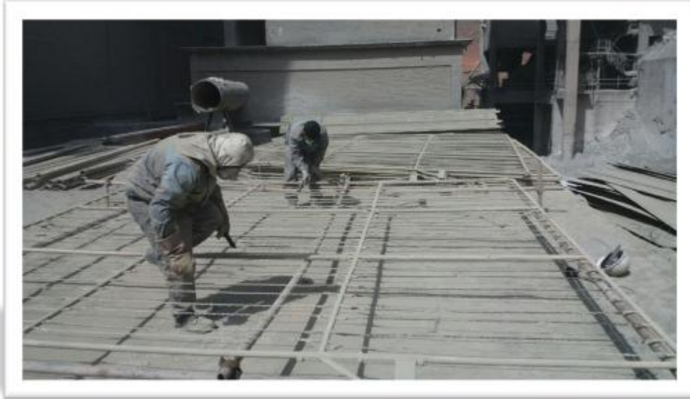
تصویر 23. نظافت الکترودهای دیسشارژ توسط برس سیمی
